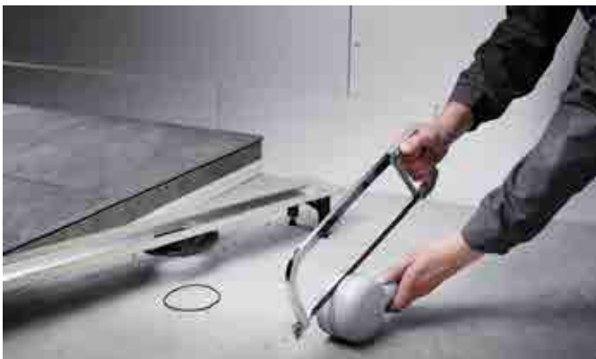
Jednostavnim skraćivanjem možete standardni odvod na mjestu ugradnje pretvoriti u model za sanaciju.
