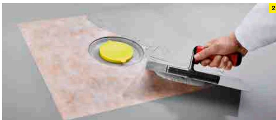
2 Nanošenje 2. sloja hidroizolacije s dvokomponentnom kombinacijom od umjetnog materijala i cementnog morta provjerenom u praksi.
